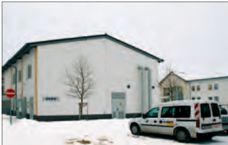
Über eine neu zu verlegende Fernwärmetrasse soll 2011 auch das Wohngebiet in der Goethestraße an das BHKW (li.) angeschlossen werden.
